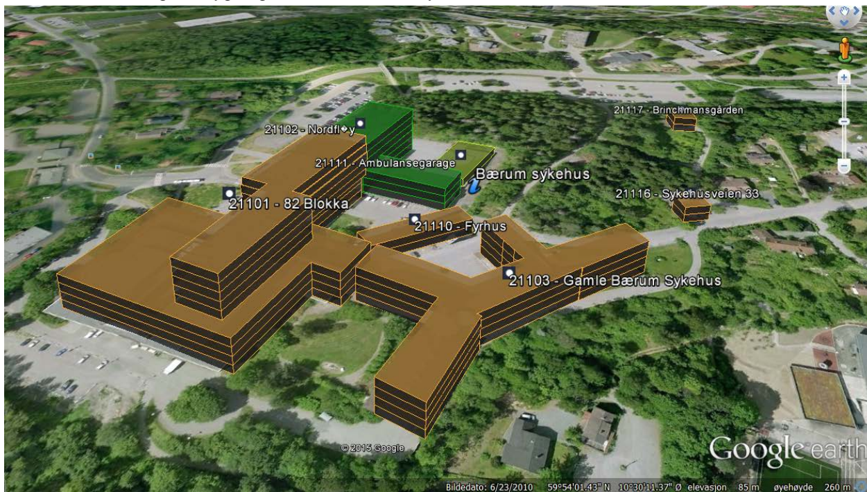
Figur 12: Bærum sykehus - teknisk status
